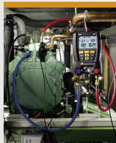
**Graças a duas sondas de temperatura conectáveis externas, o testo 550 simultaneamente calcula o superaquecimento e o subresfriamento.**
