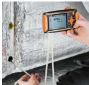
Medição com tubo de Pitot no canal.
