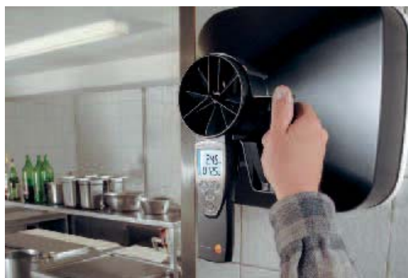
testo 417, ex. para monitoração de ar de exaustão em ventilador de parede
