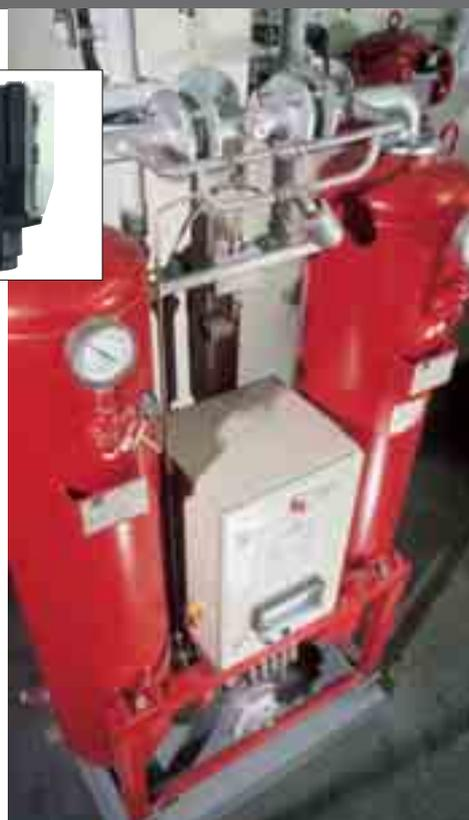
En secadores por adsorción, el testo 6740 controla no solo la traza de humedad con elevada fiabilidad, además regula de forma óptima - esto se traduce en una reducción de costes.
